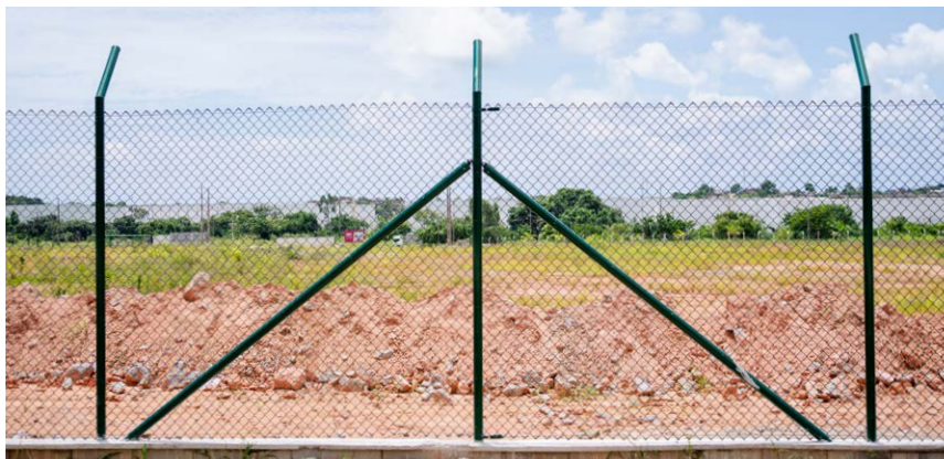
Tela alambrado - Instalação com todos os acessórios
